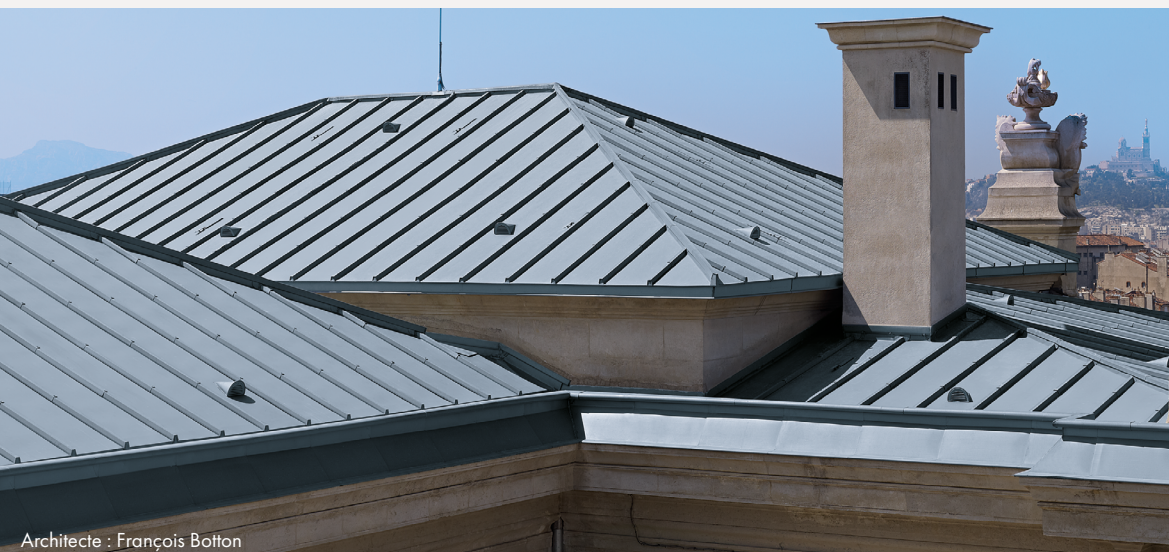
Architecte : François Botton
